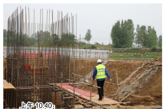
上午 10:40: 取水泵站施工现场，对钢筋绑扎、模板加固。
