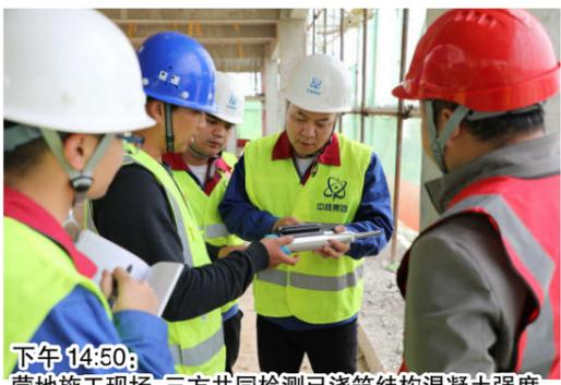
下午 14:50: 营地施工现场，三方共同检测已浇筑结构混凝土强度。
